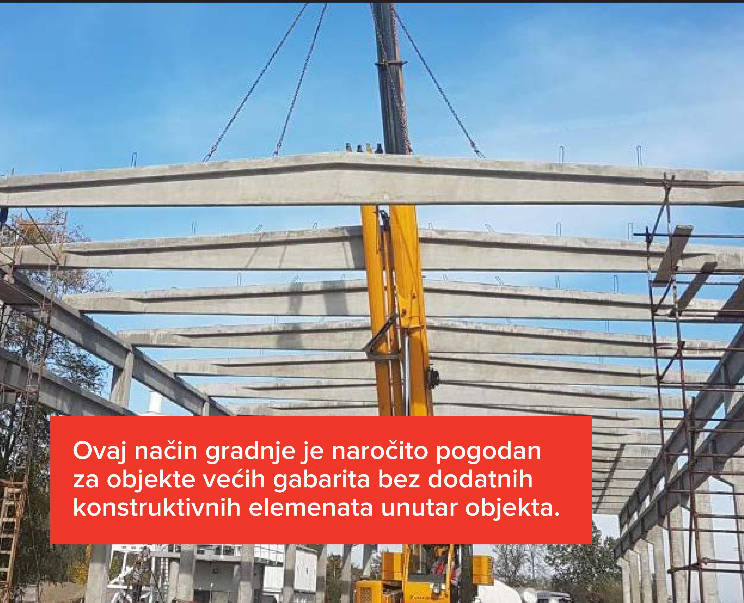
Ovaj način gradnje je naročito pogodan za objekte većih gabarita bez dodatnih konstruktivnih elemenata unutar objekta.
